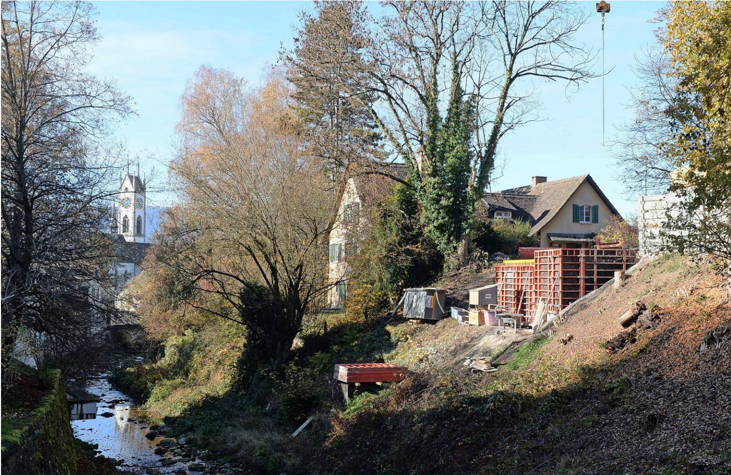
Vor fünf Jahren befand sich das Kleinkraftwerk am Dorfbach Küsnacht im Bau. Archivfoto: Reto Schneider
